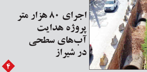
اجرای ۸۰ هزار متر پروژه هدایت آب‌های سطحی در شیراز
