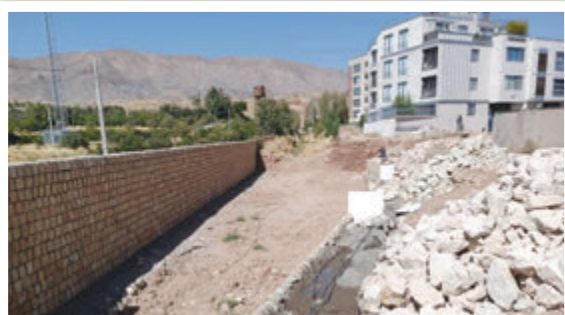
پروژه حوضچه آرامش بلوار شهید مردانی شیمی گاه پیشرفت فیزیکی: ۵۰ درصد / هدف: کنترل سیلاب و تغذیه سرفه های آب زیر زمینی و جلوگیری از ورود سیلاب به مناطق مسکونی و اطلاع از حریم رودخانه
