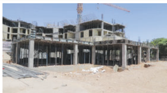
پروژه ساخت آشیانه ایستگاه آتش نشانی شماره ۸ شهرک استقلال پیشرفت فیزیکی: ۲۰ درصد / هدف: افزایش بازده ایستگاه آتش نشانی و بالا بردن سطح خدمات ایمنی و آتش نشانی در محدوده عملیاتی ایستگاه شماره ۸
