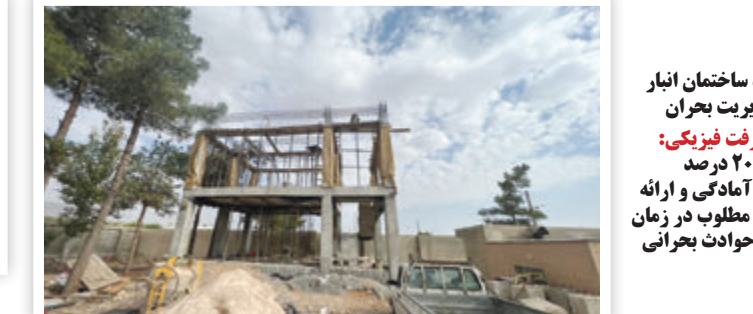
پروژه ساختمان انبار مدیریت بحران پیشرفت فیزیکی: ۲۰ درصد / هدف: آمادگی و ارائه خدمات مطلوب در زمان وقوع حوادث بحرانی
