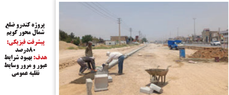
پروژه کندرو و ضلع شمال محور گویم پیشرفت فیزیکی: ۸۰ درصد / هدف: بهبود شرایط عبور و مرور وسائط نقلیه عمومی
