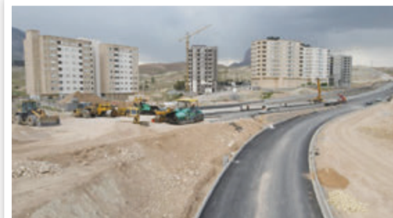
پروژه های بزرگ مقیاس در حال انجام در سطح منطقه ۱۰: پروژه ۵۵ متری حافظ
