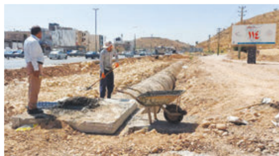
پروژه لوله گذاری دفع آبهای سطحی محور گویم سپیدان
