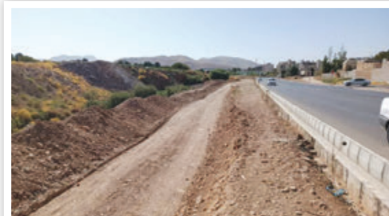
پروژه محرومیت زدایی، پیاده راه نهر اعظم واقع در شهرک حسین آباد که پیاده راه در ضلع شمال و جنوب با عرض سه متر به طول یک کیلومتر با ۱۵ درصد پیشرفت فیزیکی
